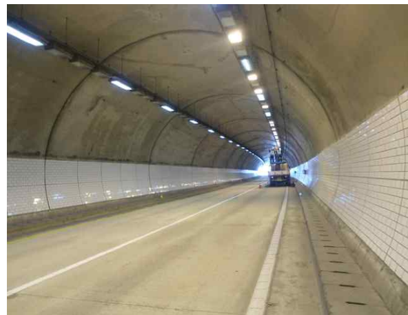
[하행선 내부 전경]
